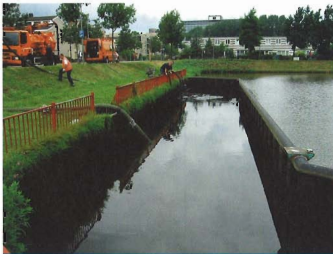
Slibverwijdering bij het onderhoud aan de bezinkvoorziening.
